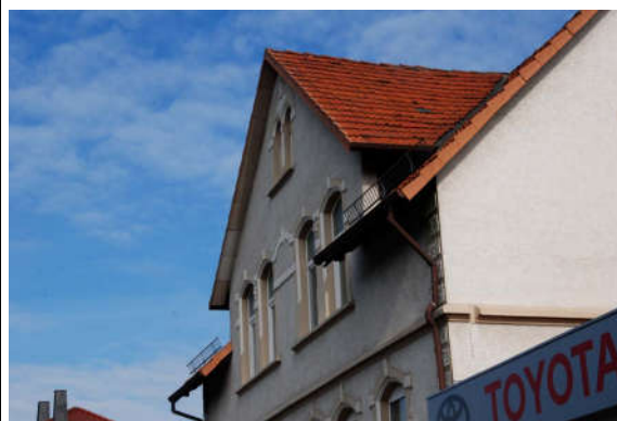
Geschlossene Abdichtung der Dachkonstruktion
