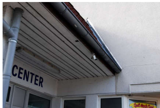
modernes Funktionsgebäude ohne Spaltenverstecke
