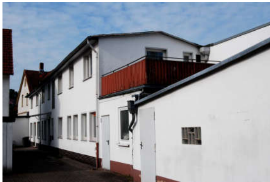
Verschachtelter verschlossen Gebäudekomplex, Dachunterseiten
