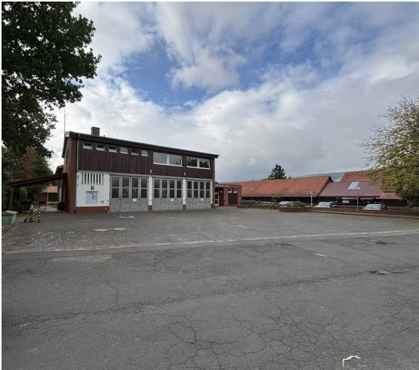
Abb. 10: Feuerwehr im Südwesten
