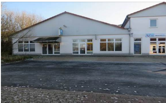
Überwiegend leerstehende Dienstleistungseinrichtungen an der Nordseite des Aldi-Marktes
