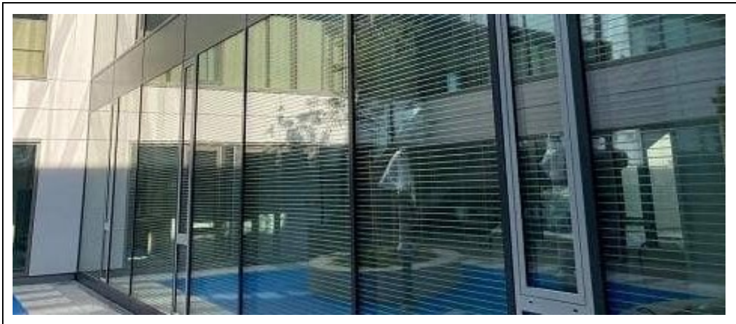
Abb. 5: Glasschutzfolie an der Außenseite eines Gebäudes auf dem Schulcampus in Unterföhring.
