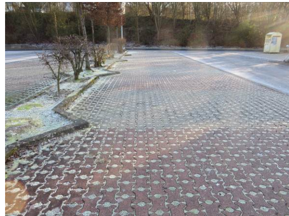
Stellplatzanlage mit Betonpflaster
