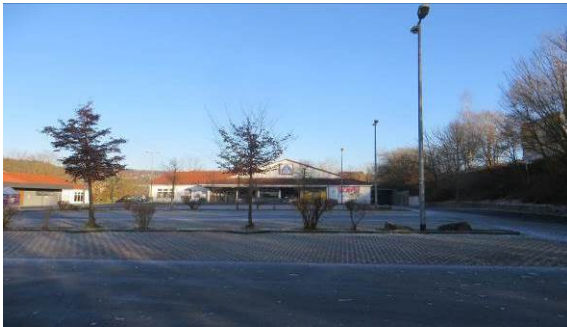
Blick von Südwesten auf den REWE-Markt
