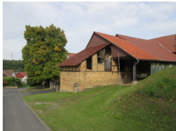
Abbildung 5: Blick von der Straße „Hergraben“ auf die Wirtschaftsgebäude und die Linde
