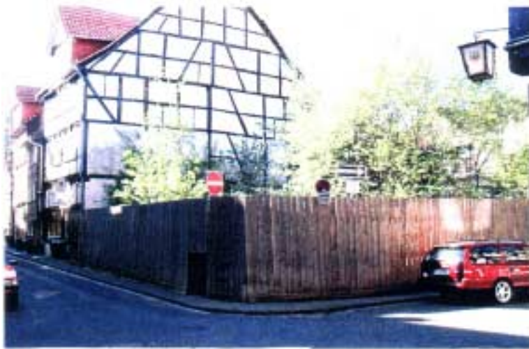
BAULÜCKE PETERSLIENSTRASSE / ZIEDELSTRASSE
